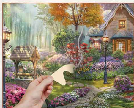
7. Удалите отрезанные полоски обоих полотен.
