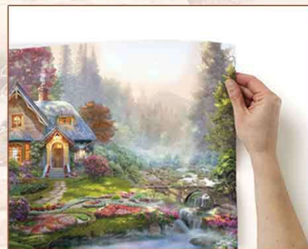
3. Покройте стену клеем и приложите к ней пропитавшееся клеем полотно.
