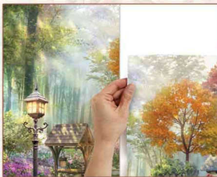
5. Последующее полотно поклейте внахлест на предыдущее, совмещая рисунок в соответствии с метками.
