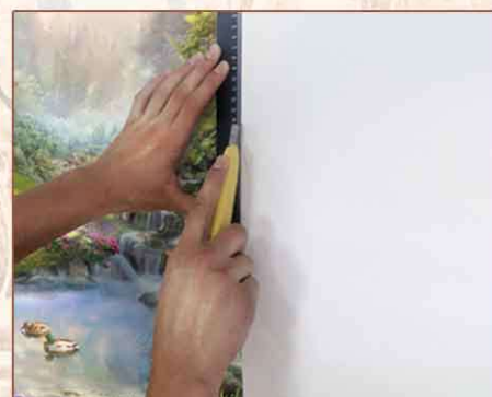
9. Край полотна подрежьте острым ножом по линейке или шпателью.
