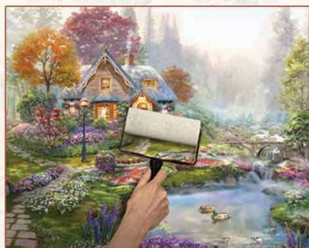
4. Складки и пузыри разгладьте валиком для обоев.
